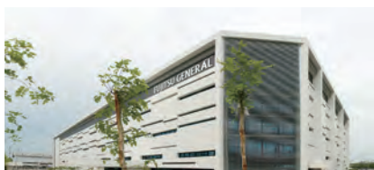
Centrum badawczo-rozwojowe w Fujitsu General Engineering (Tajlandia)
